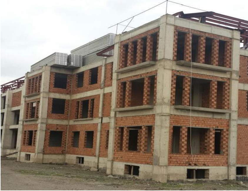
TARIM SİTESİ (İNŞAAT)
